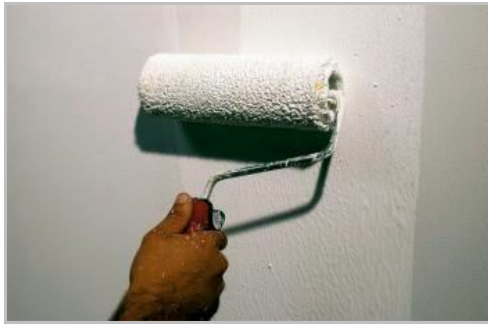
Paso 1 - Para iniciar aplica Primus Sabbia.
